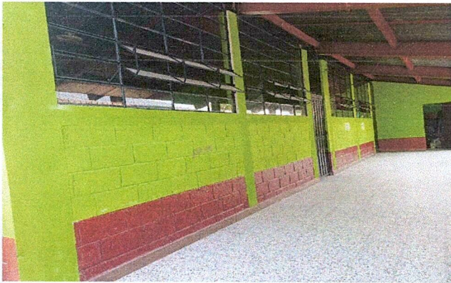
Foto 3: La ampliación de las ventanas de las aulas de preprimaria 2 y segundo grado quedaron así, con mas claridad y ventilación.
