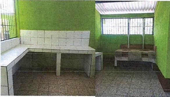
Foto 1: Así quedó la cocina en mejoramiento de polletón, encimera, techo, pintura y piso.
